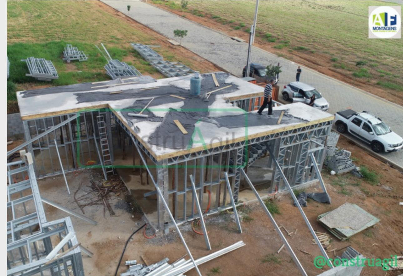
Laje impermeabilizada em concreto armado ou protendido (Estrutura LSF suporta laje)
