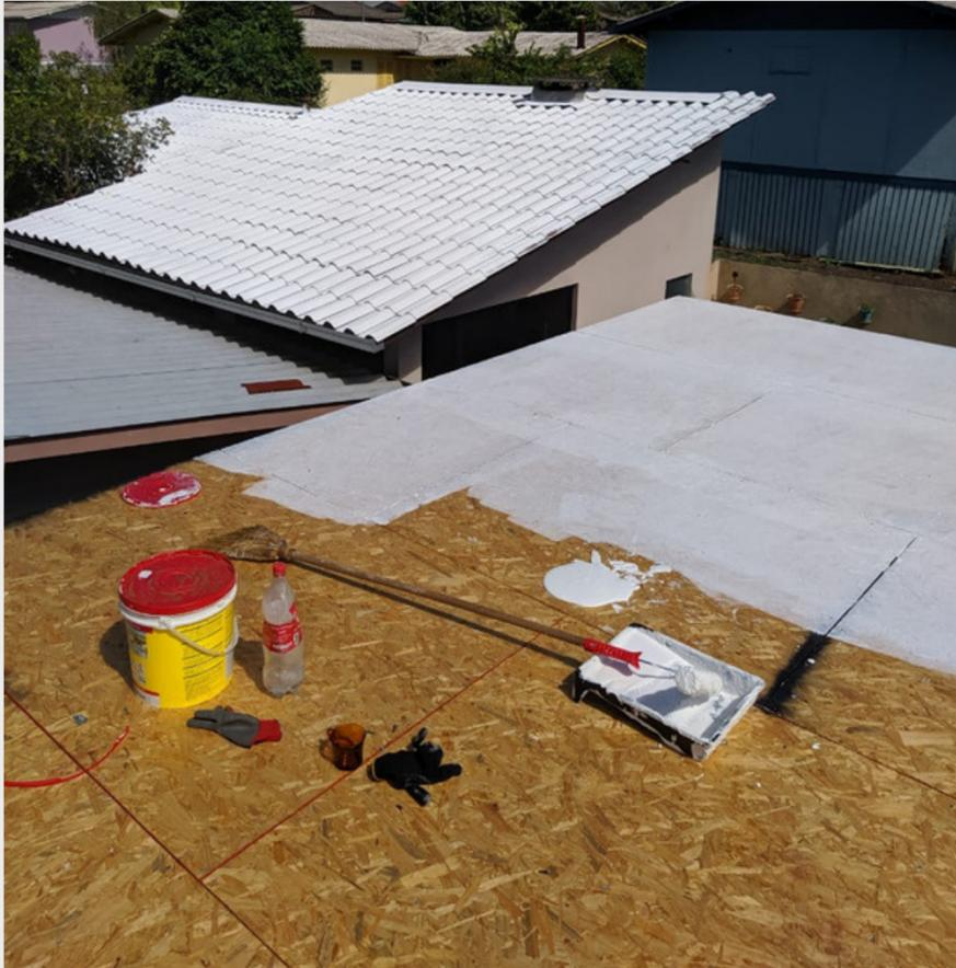
Laje impermeabilizada em LSF + Placa OSB + contrapiso
