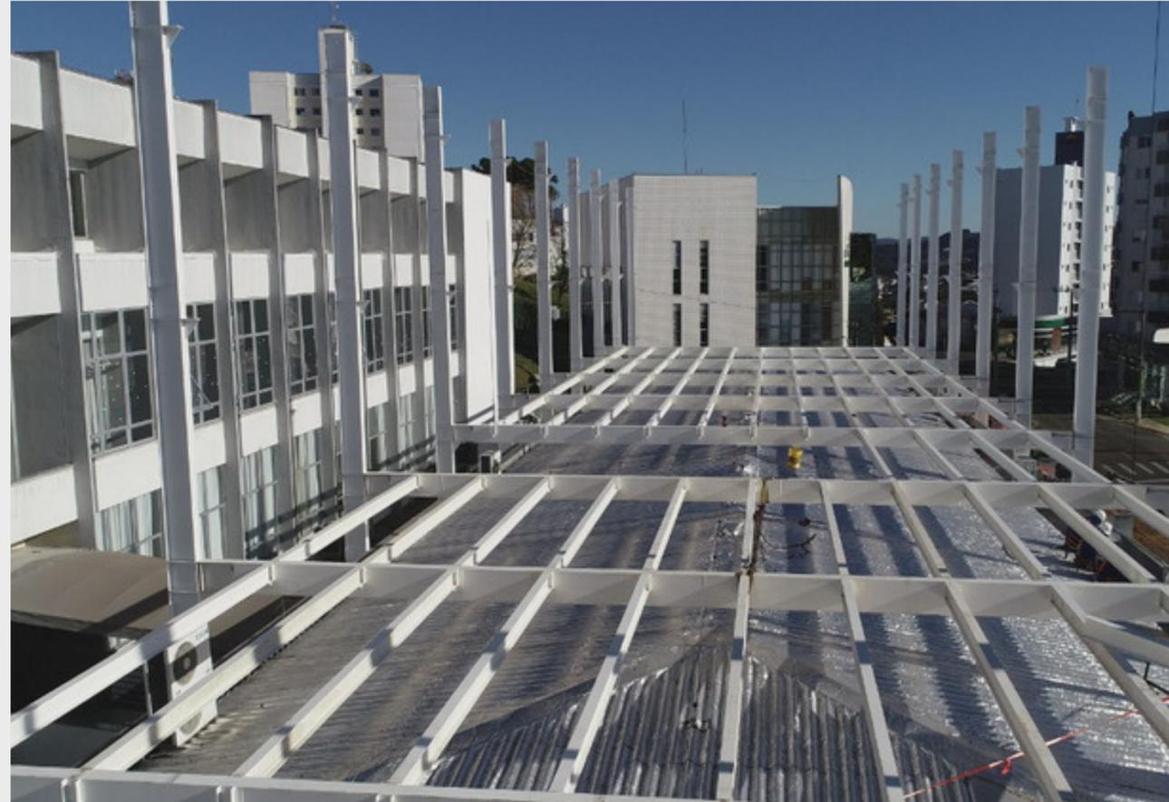
Universidade Uniarp em Caçador-SC (Vigas de aço laminado protendidas)
