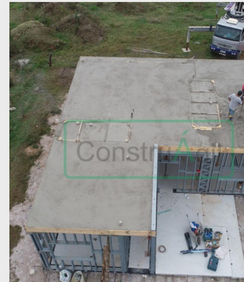
Laje impermeabilizada em concreto armado ou protendido (Estrutura LSF suporta laje)
