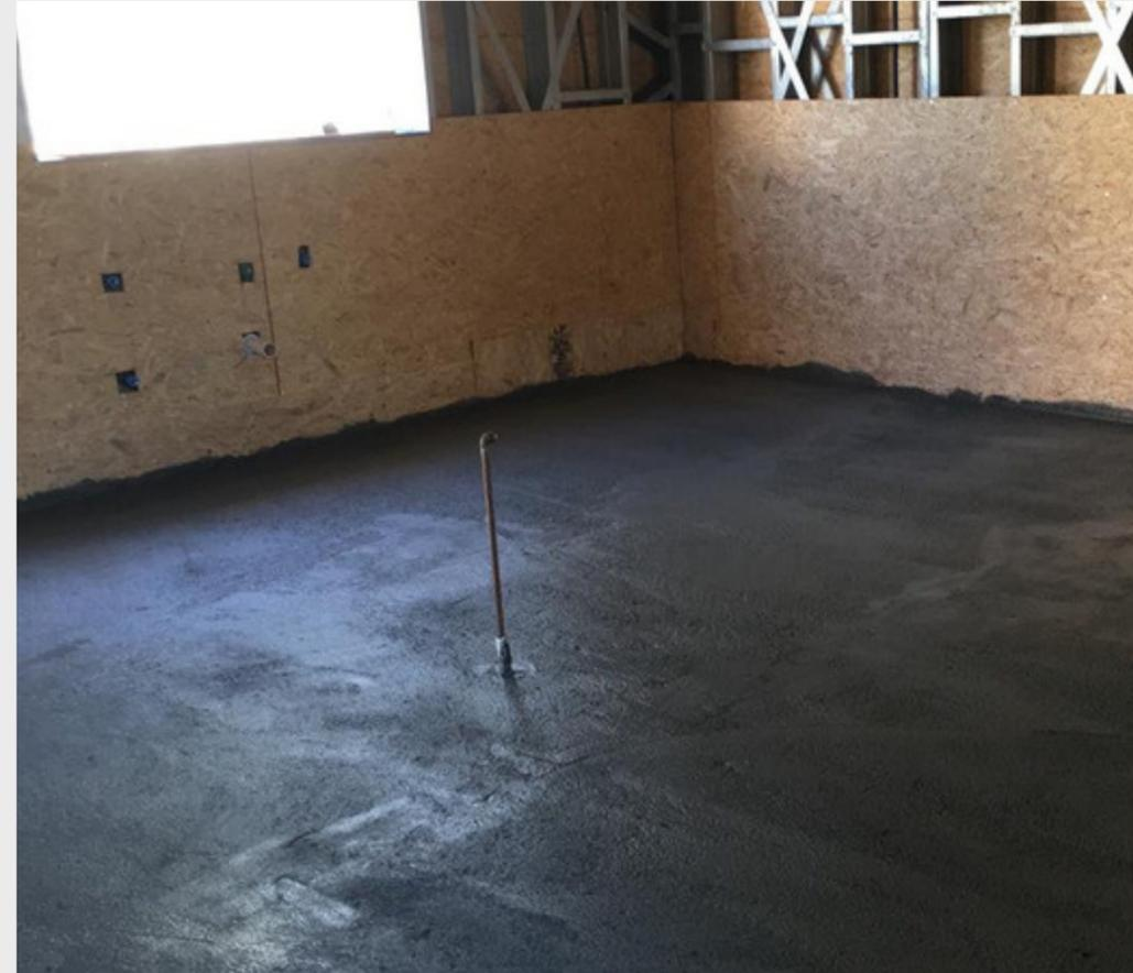
Laje impermeabilizada em LSF + Placa OSB + contrapiso
